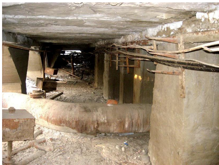
Рис. 1. Проветриваемое подполье под главным корпусом Якутской ТЭЦ (фото С. И. Заболотника, 5 ноября 2009 г.) / Fig. 1. Ventilated underground under the main building of the Yakutsk TPP (photo by S. I. Zabolotnik, November 5, 2009)
