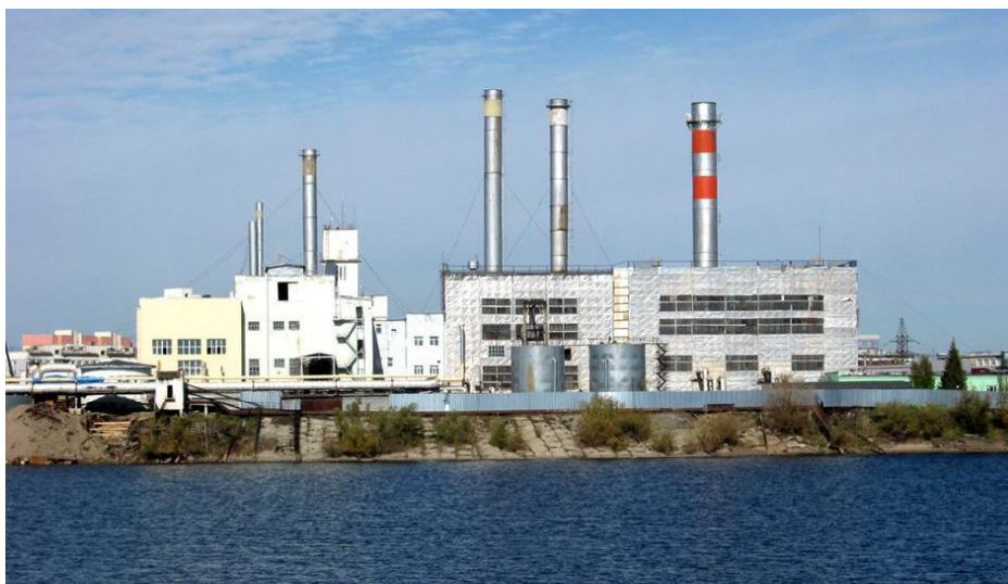
Рис. 2. Общий вид Якутской ТЭЦ (фото П. С. Заболотника, 5 сентября 2013 г.) / Fig. 2. General view of the Yakutsk TPP (photo by P. S. Zabolotnik, September 5, 2013)
